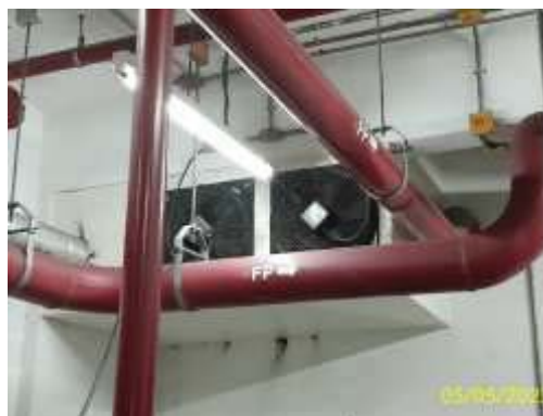
การระบายอากาศวิธีกลในห้องระบบ
